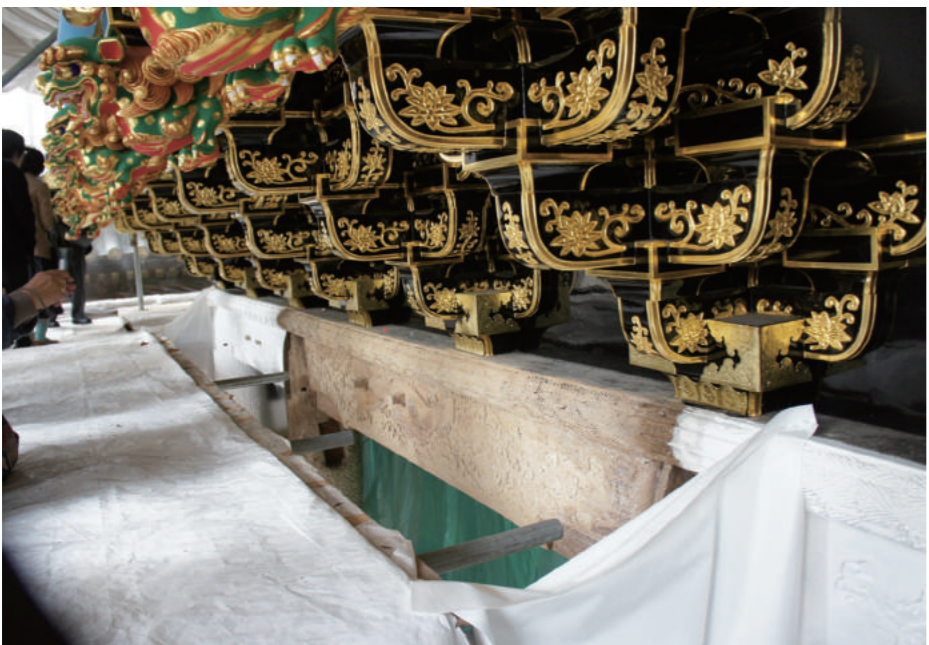
日光東照宮修復現場の見学
